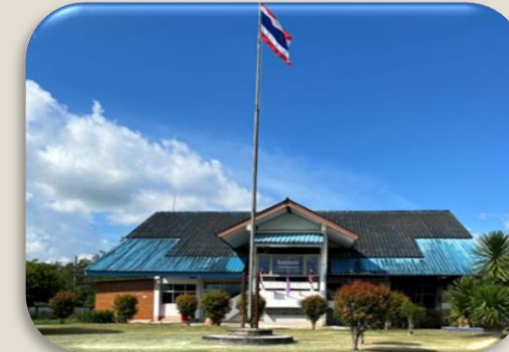
ซ่อมแซมหลังคา
